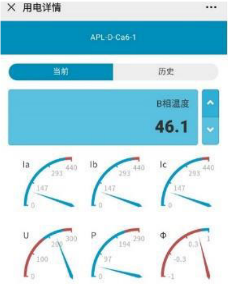
智慧用电管理系统
